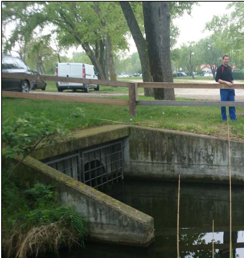
Abbildung 94: Probenahmestelle Abwasserpfad Podersdorf, Nordgraben, nach Rückhaltebecken, vor Schönungsteich
